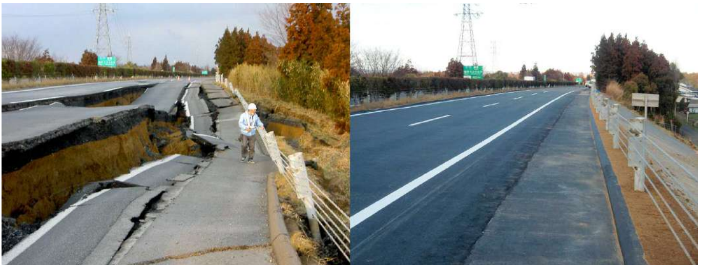
図1 東日本大震災で被害を受けた常磐道(水戸IC～那珂IC)。左は震災直後(2011年3月11日)、右は震災から6日目の3月17日の同地点。
